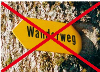
Abb. 24 Wegweiser werden nie an lebenden Gehölzen befestigt.
